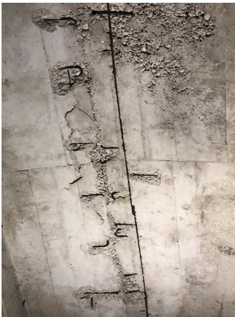
Figura 2-1 Espulsione di copriferro intradosso soletta e nidi di ghiaia
