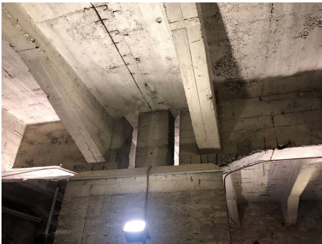
Figura 1-6 Intradosso solaio (pilastro centrale, appoggio travi principali)
