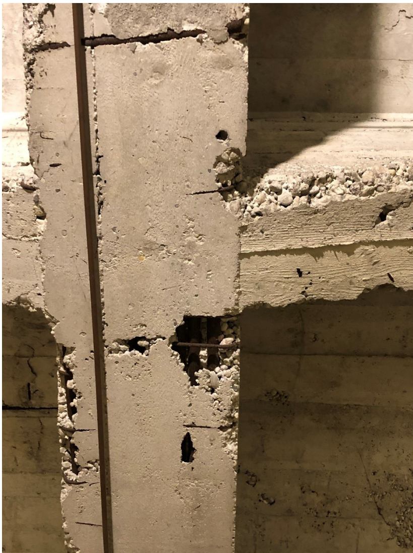
Figura 2-4 Espulsione di copriferro con cavità intradosso trave principale, nidi di ghiaia agli spigoli, copriferro assente sulle staffe
