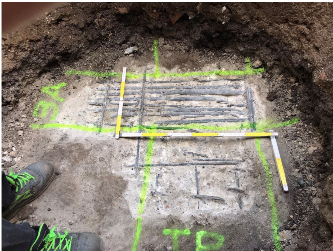
Figura 2-5 Buona condizione di conservazione delle barre superiori, assenza di ruggine (dopo scarifica copriferro per rilievo armature)
