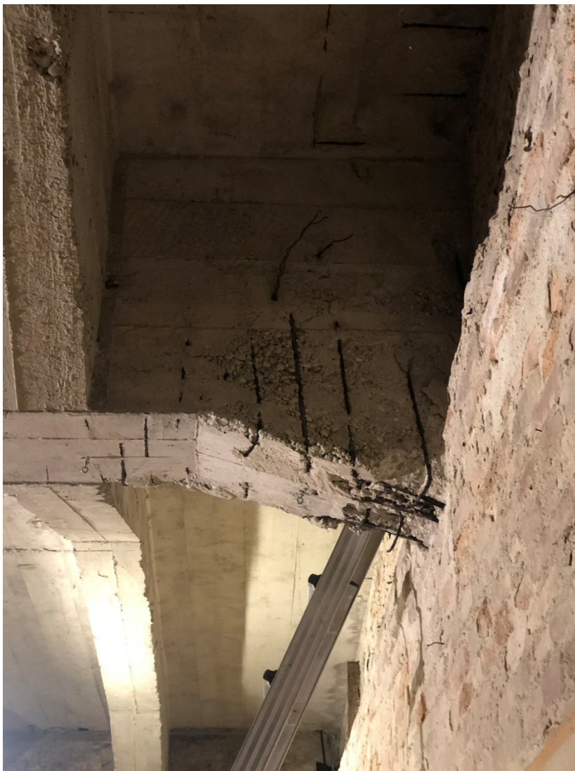
Figura 2-3 Espulsione di copriferro intradosso trave principale, rottura ferri e staffe, nidi di ghiaia, copriferro assente sulle staffe
