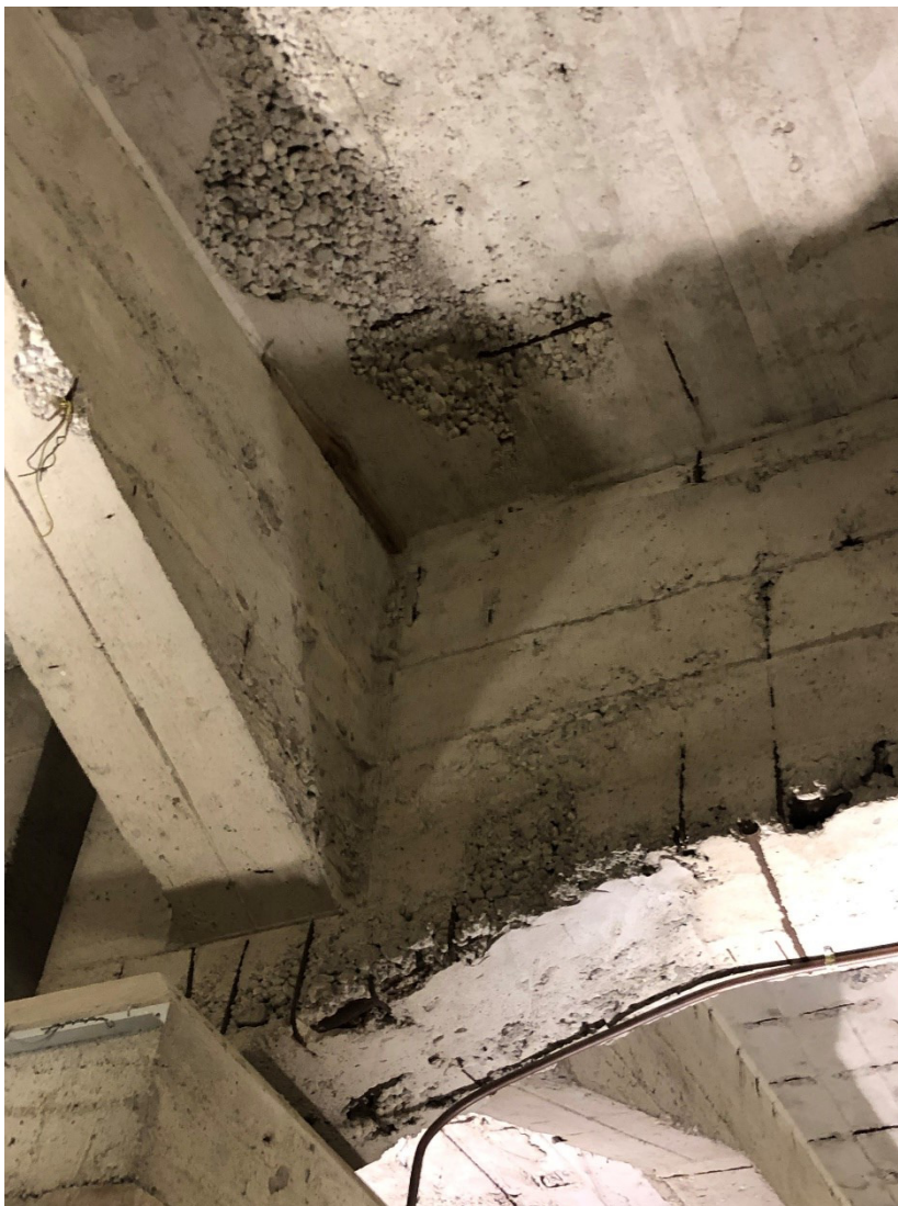
Figura 2-2 Espulsione di copriferro intradosso soletta e trave principale all'appoggio, nidi di ghiaia, copriferro assente sulle staffe
