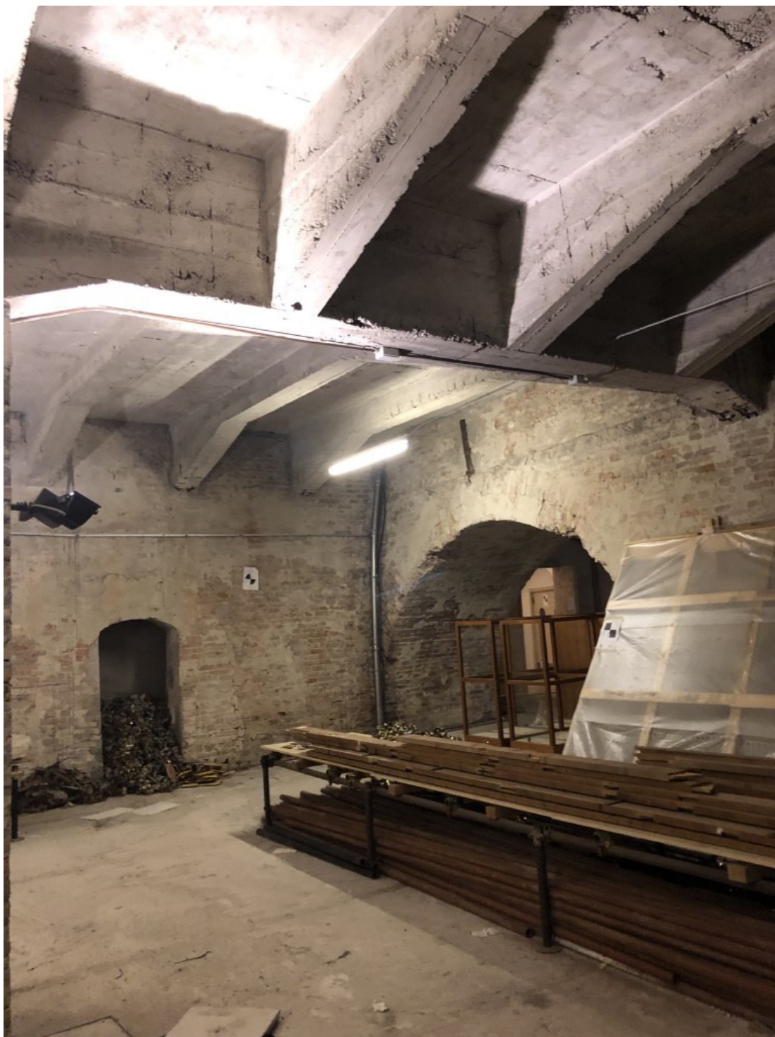
Figura 1-8 Intradosso solaio (trave principale e secondaria, muro OVEST con archi)
