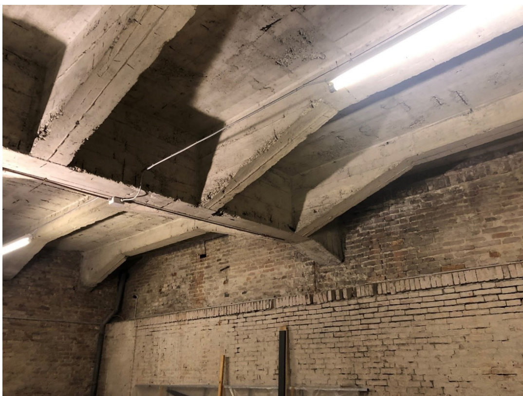
Figura 1-7 Intradosso solaio (trave principale e secondarie, muro EST con contromuro)
